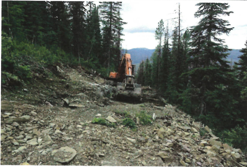
Hitachi 270 excavator hoe
