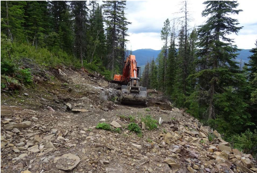
Hitachi 270 excavator hoe
